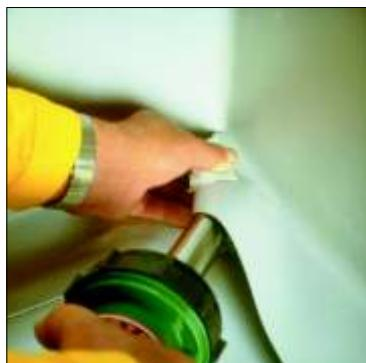
Полностью заварите сгиб полосы мембранны в направлении от вершины угла наружу. Не забудьте выступающую мембрану приварить на поверхность кровли.
