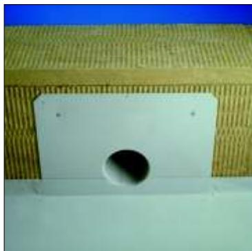
Установите переливную воронку и закрепите минимум четырьмя саморезами. Пожалуйста, обратите внимание, что горизонтальная часть этой детали должна находиться под кровельной мембраной. Очистите поверхность, подлежащую сварке.
