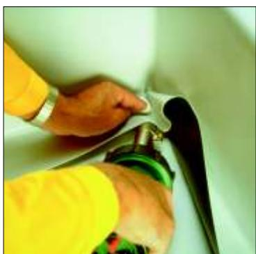
Закрепите полосу мембранны Sikaplan® прихватками у места перегиба вдоль плоскости кровли и тщательно сварите ее в угол. Обратите внимание: ширина нахлестки зависит от типа механического крепления по периметру и должна составлять не менее 12 см (см. главу 4.14.).
