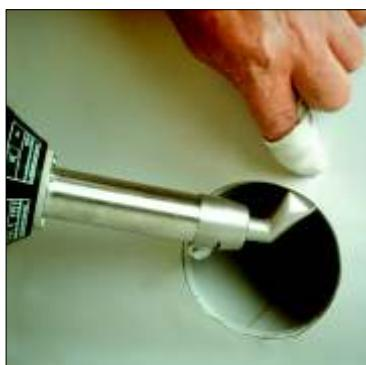
Приварите неармированную кровельную мембрану, облицовывающую вертикальную поверхность, к фартуку переливной воронки.
