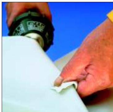
Сварите складку из кровельной мембранны по всей её поверхности.
