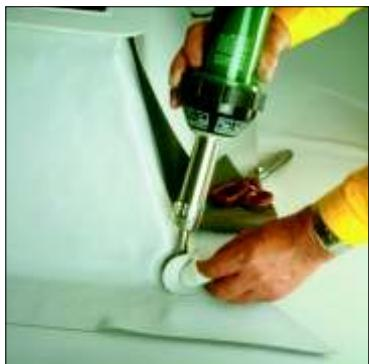
Сварите все боковые выкройки с горизонтальной кровельной мембрани. Приварите круглые рондели из неармированной мембрани на каждый угол (диаметр 5 см).
