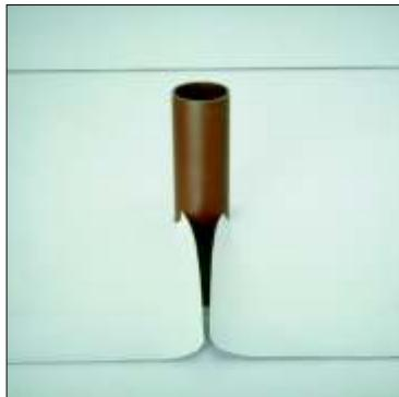
Разрежьте рулон кровельной мембранны перпендикулярно к ее продольному направлению и вырежьте отверстие по диаметру выходного отверстия.
