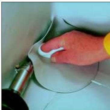
Приварите угловую накладку вдоль углов от вершины угла к краю накладки.
