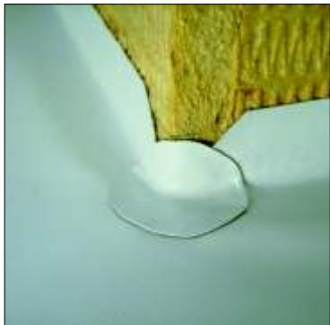
Во время выполнения работ необходимо принять все меры для предотвращения попадания воды в кровельный «пирог». Кровельную мембрану укладывают с подъемом на вертикальную поверхность не менее 5 см над плоскостью кровли. Для обеспечения надежности в углу наваривают круглый рондель из неармированной мембранны.
