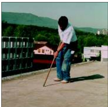
Разрежьте кровельную мембрану на полосы шириной 1 м.
