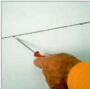
Проверяйте все сварные швы отверткой № 2. (размер шлица 4-6 мм)
