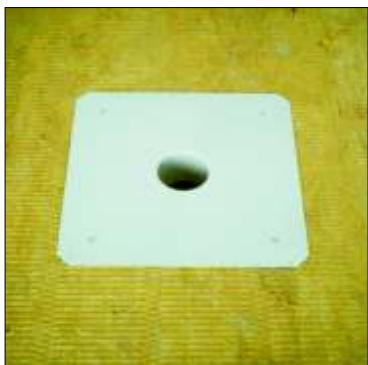
Установите воронку и закрепите ее как минимум четырьмя саморезами. Поверхности, которые подлежат сварке, обработайте очистителем мембран Sikal-Tgocal.
