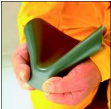
Вырежьте кружок из неармированной мембраны Sikaplan 18D или Trocal S. Его диаметр должен быть достаточным, чтобы перекрыть обе полосы не менее, чем на 30 мм. Нагрейте край кружка и растяните его. Если вы используете готовые формованные угловые накладки Corner 1, вам не придется этого делать.
