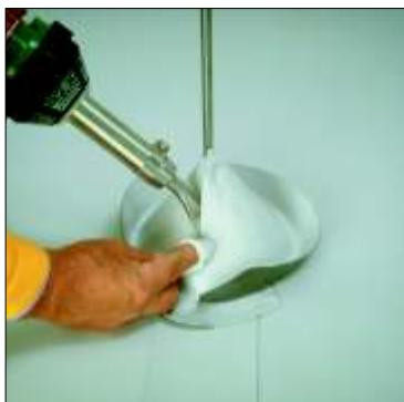
Сварите вертикальный шов выкройки, а затем приварите ее на на кровельную мембрану. Используйте сопло 20 мм.
