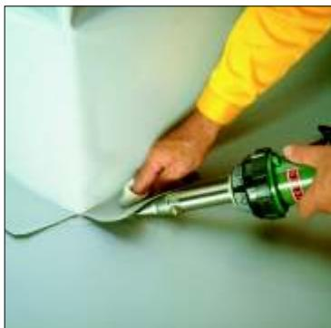
Облицуйте отбортовку полосой мембранны. Закрепите полосу мембранны прихватками у места перегиба вдоль плоскости кровли. Обратите внимание: ширина нахлеста зависит от типа механического крепления по периметру и должна составлять не менее 12 см (см. главу 4.14.).
