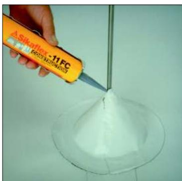
Заполните примыкание к штырю герметиком. Зафиксируйте мембрану вверху штыря зажимным хомутом.
