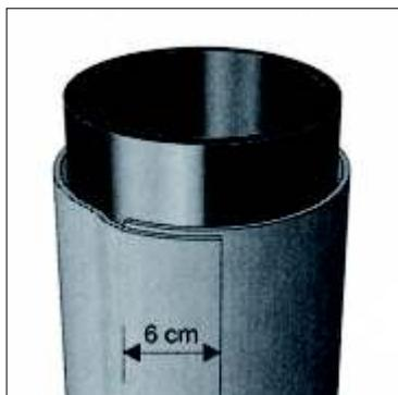
Отмерьте и отрежьте кусок неармированной мембранны. К длине окружности изолируемой вентиляционной трубы необходимо прибавить 6 см на нахлест шва.
