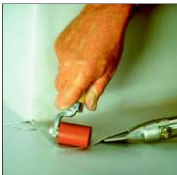
Полностью приварите нахлест обеих полос к поверхности кровельной мембранны.
