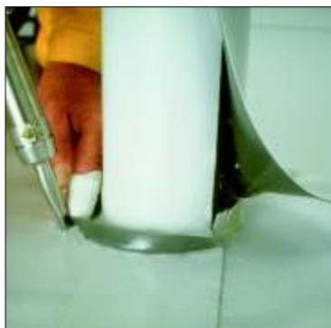
На последнем этапе сварки держите ручной сварочный аппарат вертикально, чтобы избежать расслоения и прожогов материала.
