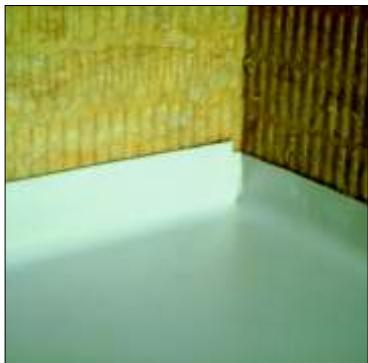
Во время выполнения работ необходимо принять все меры для предотвращения попадания воды в кровельный «пирог». Кровельную мембрану укладывают с подъемом на вертикальную поверхность вдоль угла перегиба на 5 см над плоскостью кровли. Загните внутренний угол в вертикальном направлении и заварите сгиб.
