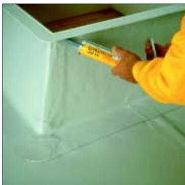
Примыкание светового фонаря в верху необходимо загерметизировать с помощью **Sikaflex-11 FC** или аналогичным герметиком.
