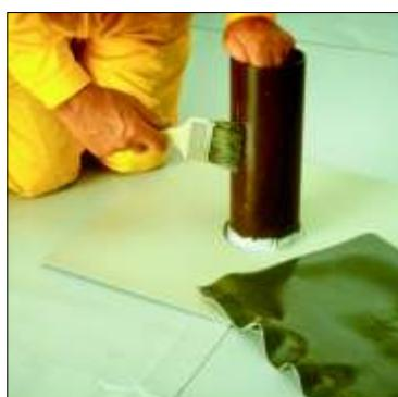
Нанесите контактный клей С 733 на трубу и подготовленную выкройку
