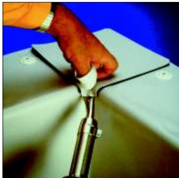
Тщательно приварите подготовленный прямоугольник по всей поверхности к мемbrane на изолируемом углу. Используйте узкое сопло шириной 20 мм.
