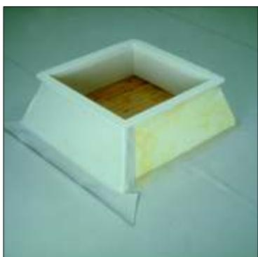
Приклейте первую выкройку из мембраны **Sikaplan®** к боковине светового фонаря контактным клеем С 733.
