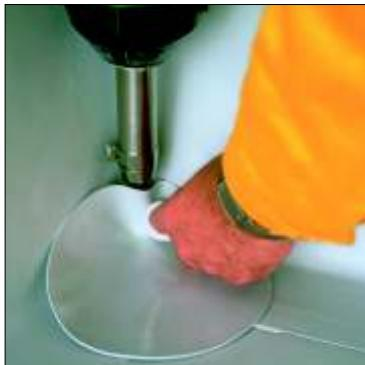
Сначала приварите готовую угловую накладку в вершине угла.
