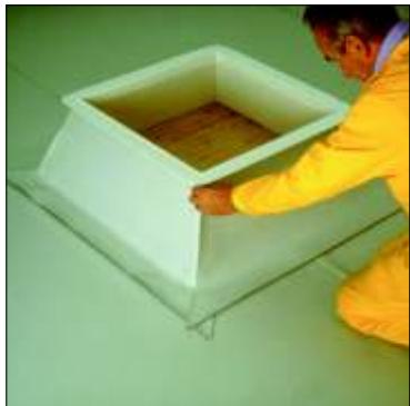
Приклейте остальные выкройки на световой фонарь контактным kleem C 733.
