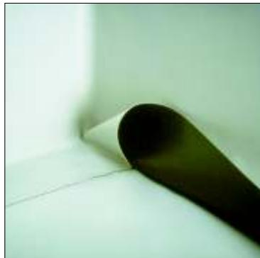
Полностью приварите полосу мембранны Sikaplan® с одной стороны угла на поверхность кровли.
