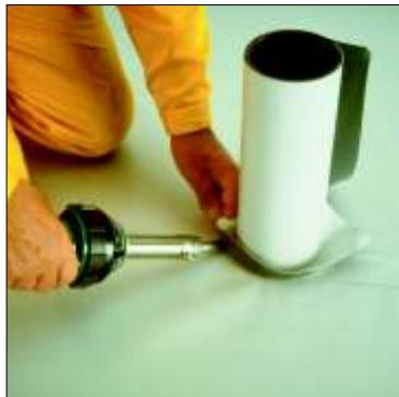
Приварите растянутый край мембранны без клеящего вещества в несколько этапов. Используйте сопло шириной 20 мм. Начните с нижней контактной поверхности в направлении вперед. Защищайте пальцы с помощью влажной тряпки.
