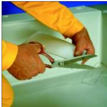
Отрежьте прямоугольный кусок неармированной мембранны **Sikaplan®**. Он должен быть одной ширины с парапетом. Закруглите на нем все углы.
