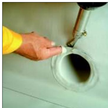
Установите рукав из **Sikaplan®** в переливную трубу и приварите его воротник к кровельной мембране. Если Вы сомневаетесь в качестве сварки, приварите сверху для надежности кольцо из мембранны (см. главу 4.12.).
