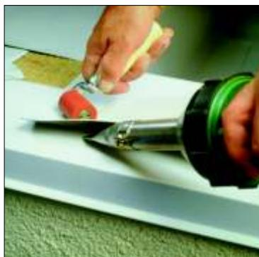
Поскольку ламинированная жесть обладает высокой теплопроводностью, сварка проводится в два этапа:
