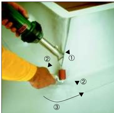
Сварите вертикальные швы на всех четырех угловых гранях светового фонаря, начиная снизу вверх. Затем приварите все углы на горизонтальную кровельную мембрану.
