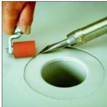
Приварите кровельную мембрану к Фартуку водосливной воронки.
