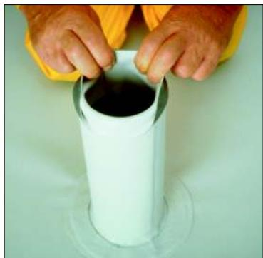
Вставьте этот сваренный рукав в изолируемую трубу и отогните их наружу. Нагретую мембрану намного легче укладывать.
